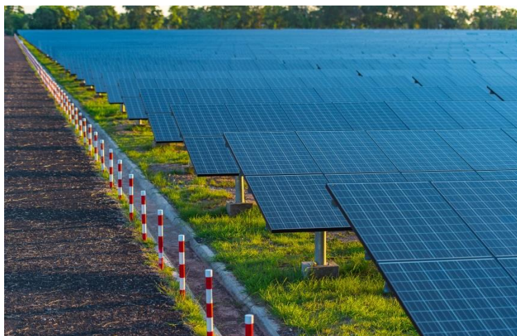
โครงการโซลาร์ฟาร์ม (โคราช 5) แบบ Photovoltaics
