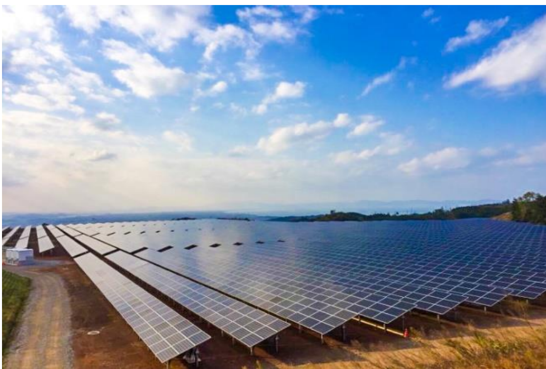
โครงการ Tottori Yonago Mega Solar Farm ณ เมืองทอตโตะริ ประเทศญี่ปุ่น
