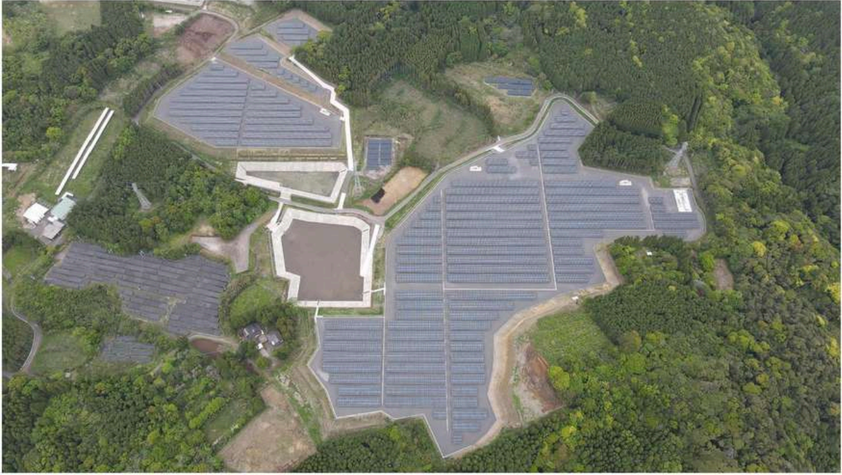
โครงการ Kagoshima Ohura Mega Solar ณ เกาะคิวชู เมืองคาโงชิมะ จังหวัดคาโกชิม่า ประเทศญี่ปุ่น
