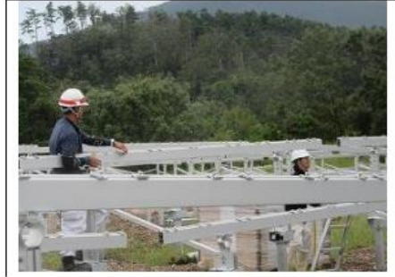
第6エリア 架台組立
