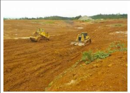
第5エリア 土工(掘削・盛土)
