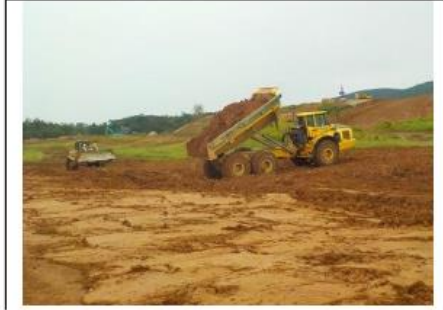
第5エリア 土工(掘削・盛土)
