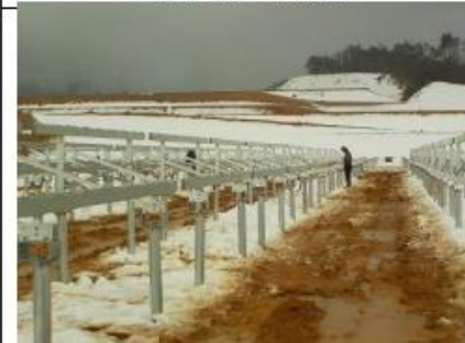
第7エリア 杭打設
