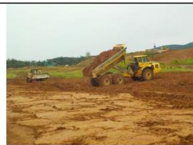
第5エリア 土工(掘削・盛土)
