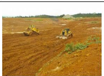
第5エリア 土工(掘削・盛土)
