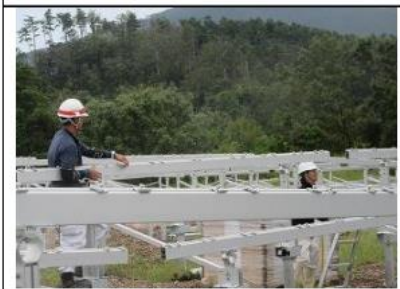
第6エリア 架台組立
